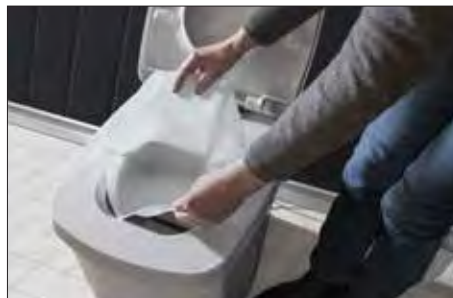
Pussin asettamisella varmistetaan jätteiden putoamisen palokammioon.
